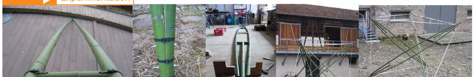
Puis, nous sommes passé à l'échelle 1, et avons construit en atelier des profils bidimensionnels en bambous de 5 mètres de long, afin d'expérimenter leur comportement (assemblages, renforts en résine aux extrémités des barres). Ceci nous a ensuite permis de monter un premier auto-tendant à trois barres, (avec du ruban de nylon d'emballage en guise d'élément de tension) ainsi que de vérifier la solidité de l'ensemble.
